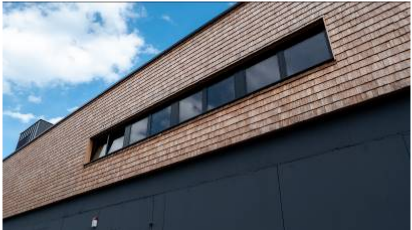
Afbeelding 2: Er werden 70 draai-/kiepramen uit de HUECK Lambda WS 075 serie geïnstalleerd, in combinatie met HUECK Gen 4.0 hang- en sluitwerk (Bron: HUECK)
