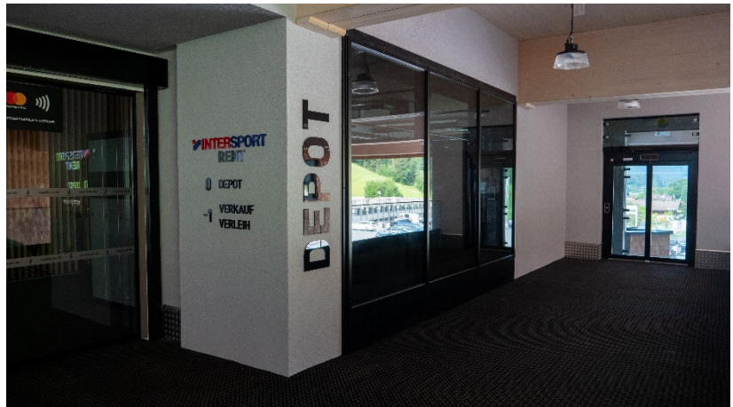
Afbeelding 3: Met de series HUECK Lava 77-30 en HUECK Lambda DS 075 werden in totaal 50 vlucht- en brandwerende deuren gerealiseerd (Bron: HUECK)
