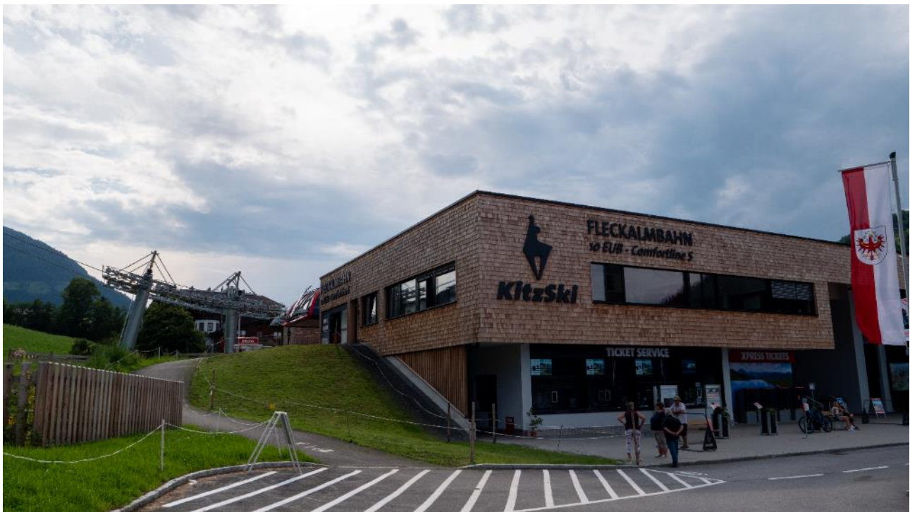
Afbeelding 1: Met de nieuwbouw van de Fleckalmbahn werd de op één na belangrijkste skilift naar het centrale skigebied van Kitzbühel gemoderniseerd. (Bron: HUECK)
