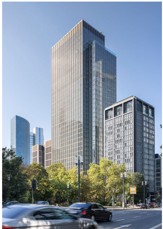
Abbildung 1: Der 38-geschossige Marienturm wächst aus einem Sockel, der den Straßenlinien folgt. Mit seiner klaren prägnanten Form fügt er sich harmonisch in die Skyline des Frankfurter Bankenviertels. (Bildquelle: ©Pecan Development)
