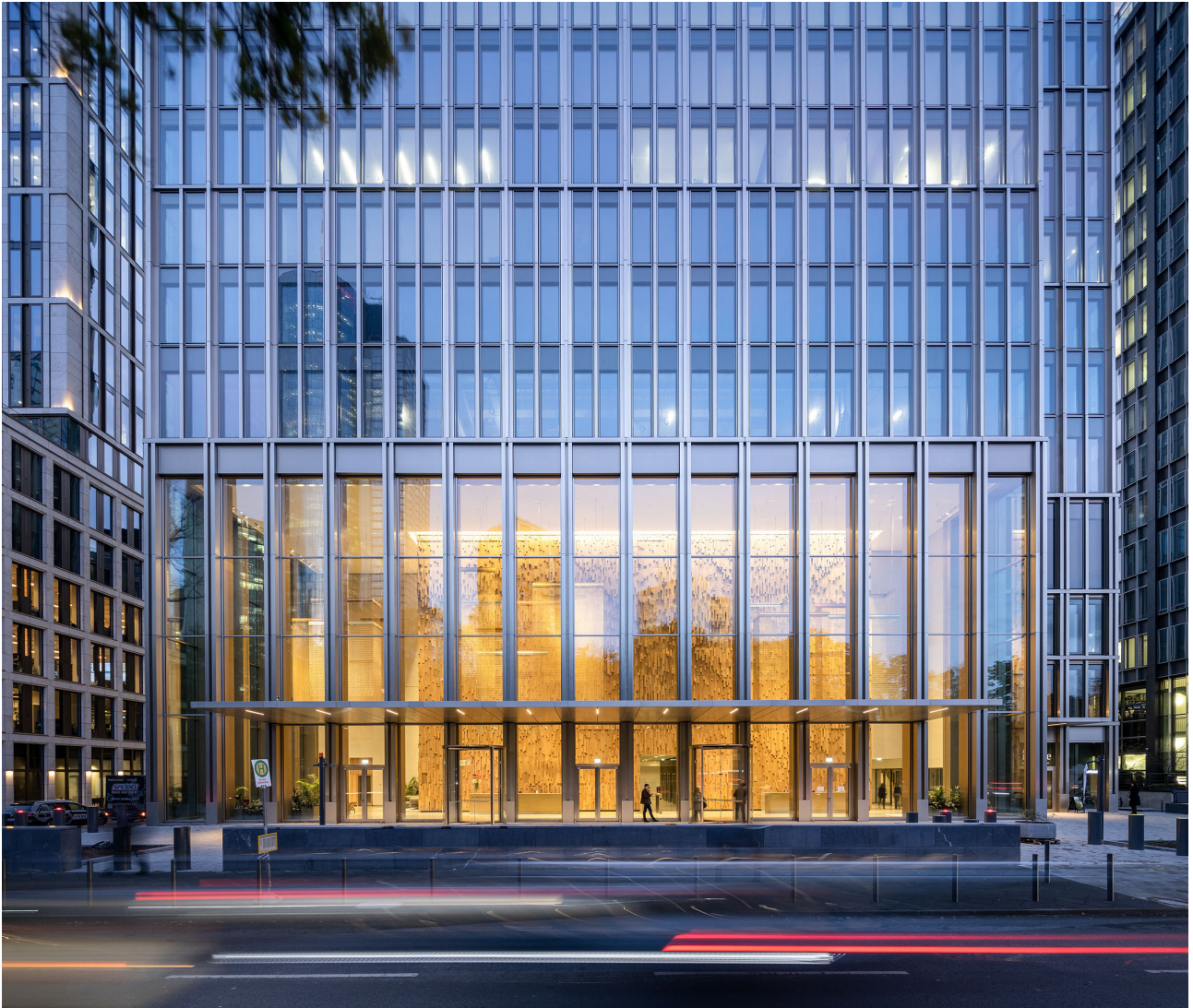
Abbildung 3: Die prägnante, vertikal gegliederte Fensterfassade aus Glas und eloxiertem Aluminium des vier Stockwerke hohen Eingangsbereichs wurde mit einer Pfosten-Riegel-Fassade der Serie HUECK Trigon 60 umgesetzt. (Bildquelle: ©Pecan Development)
