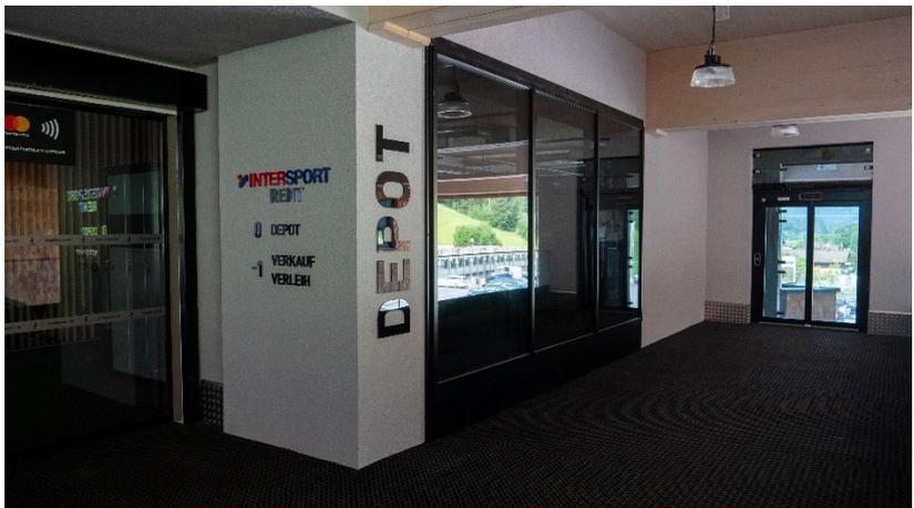
Abbildung 3: Insgesamt 50 Fluchtweg- und Brandschutz-türen wurden in den Serien HUECK Lava 77-30 und HUECK Lambda DS 075 realisiert (Quelle: HUECK)
