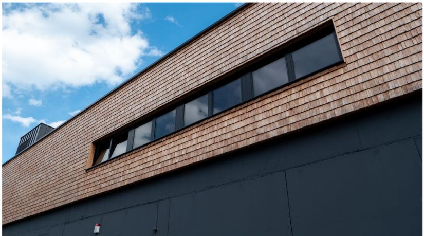
Abbildung 2: Es wurden 70 Dreh-Kipp-Fenster der Serie HUECK Lambda WS 075 kombiniert mit HUECK Gen 4.0 Beschlägen verbaut (Quelle: HUECK)
