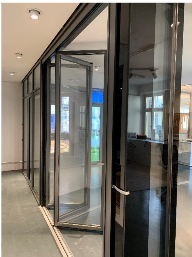
Abbildung 2: Eine Solarlux-Faltanlage wurde direkt in die Hueck-Fassade integriert (Quelle: Hueck)
