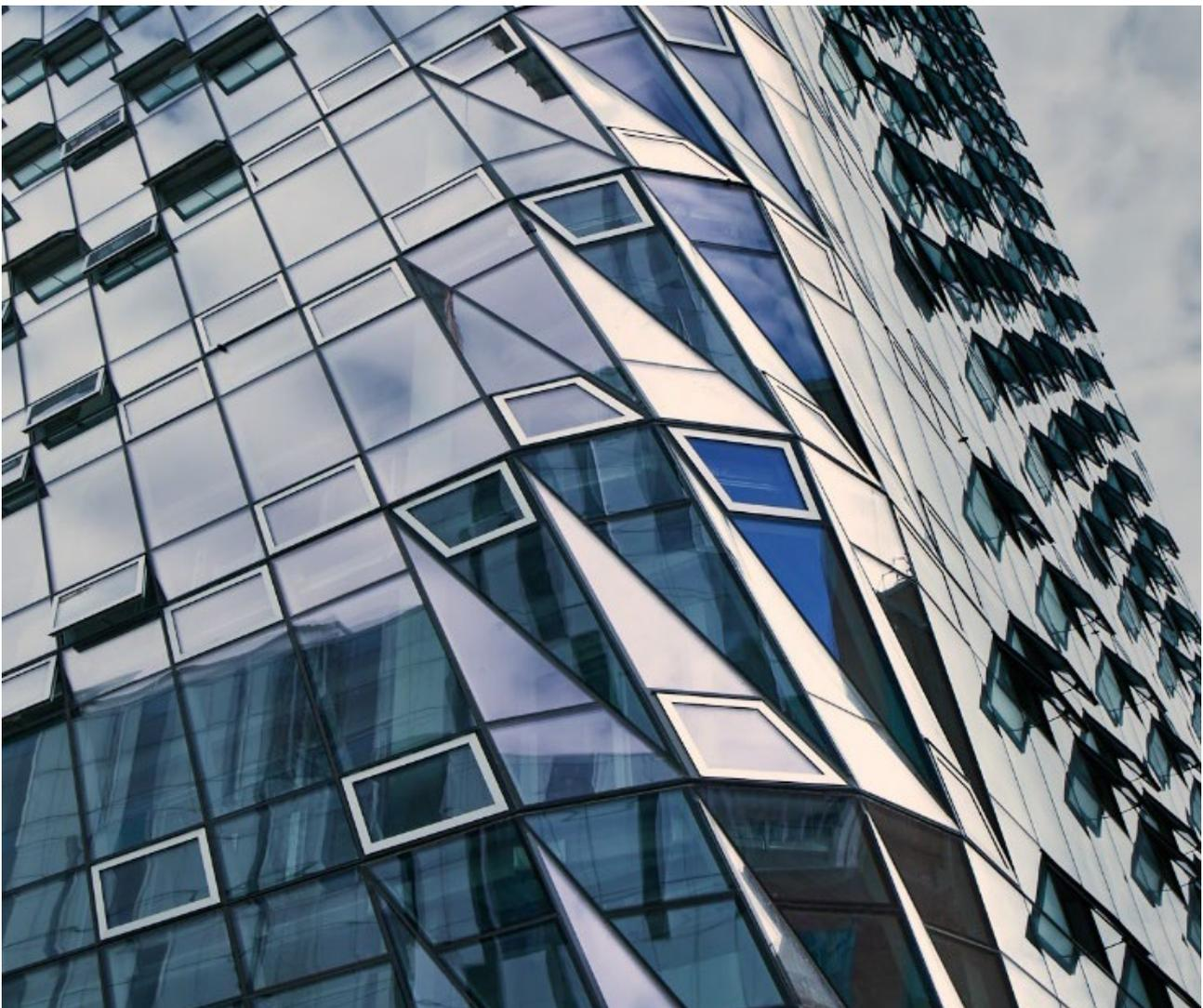
Abbildung 1: Verdeckte Motoren ermöglichen das automatische Öffnen und Schließen der Fenster, die vom Gebäudemanagementsystem gesteuert werden, wobei die harmonische Fassadenoptik erhalten bleibt (Quelle: Hueck)
